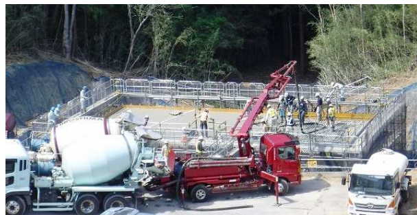
北側調整池（埋設部）コンクリート打設
