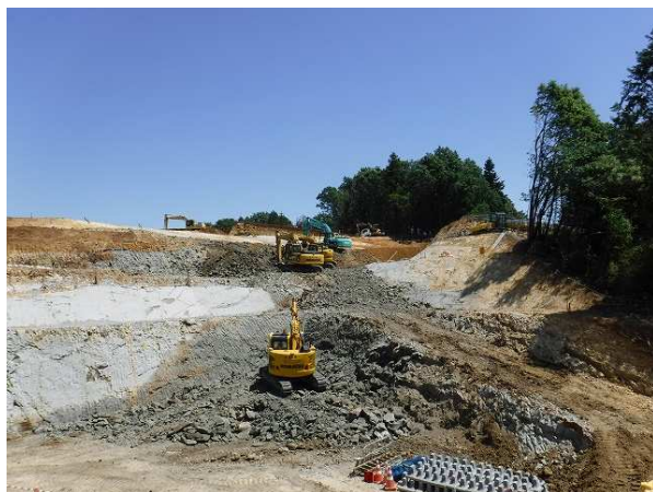
切土・残土搬出状況
