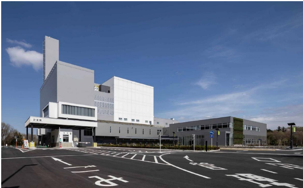
●施設入口側より
