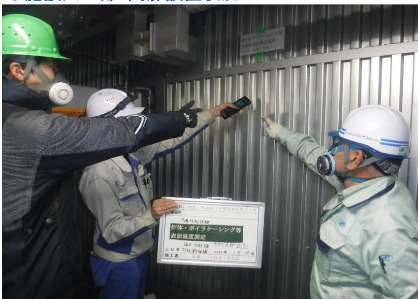
●予備性能試験（機器表面温度測定）実施状況
