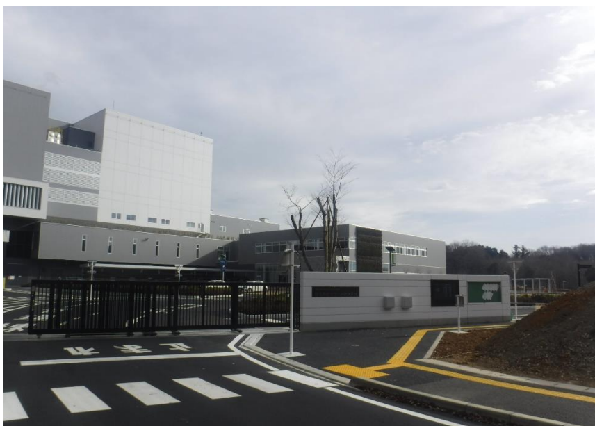
●施設入口部 門扉設置状況
