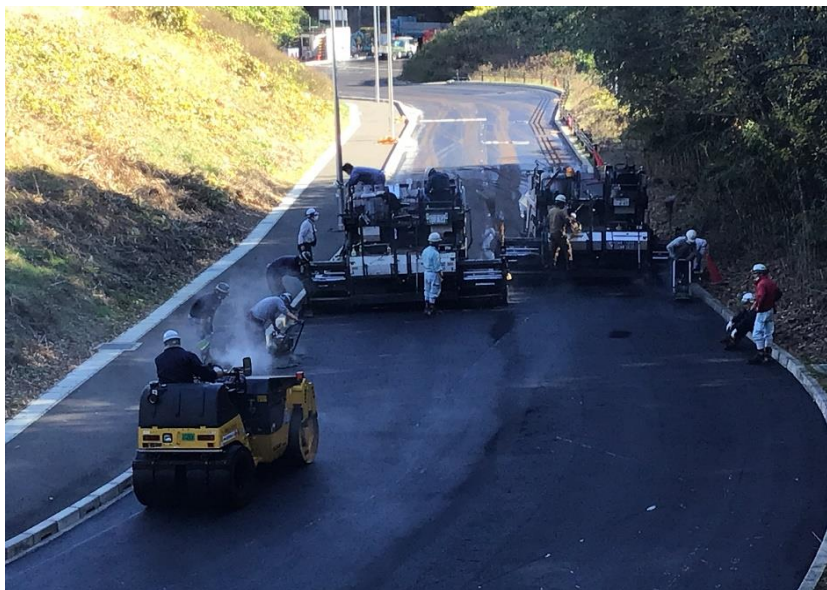
● 進入路舗装状況
