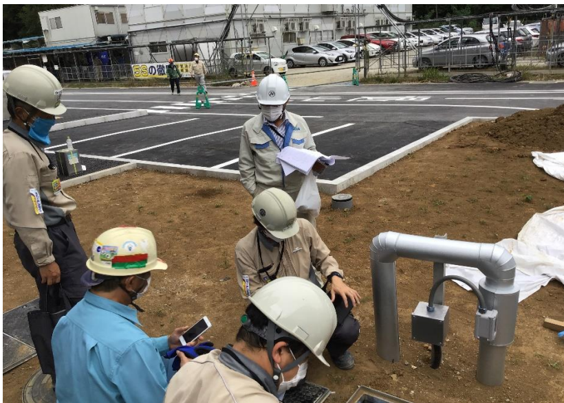
● 建築確認検査状況 1（令和 4 年 1 0 月 5 日）
