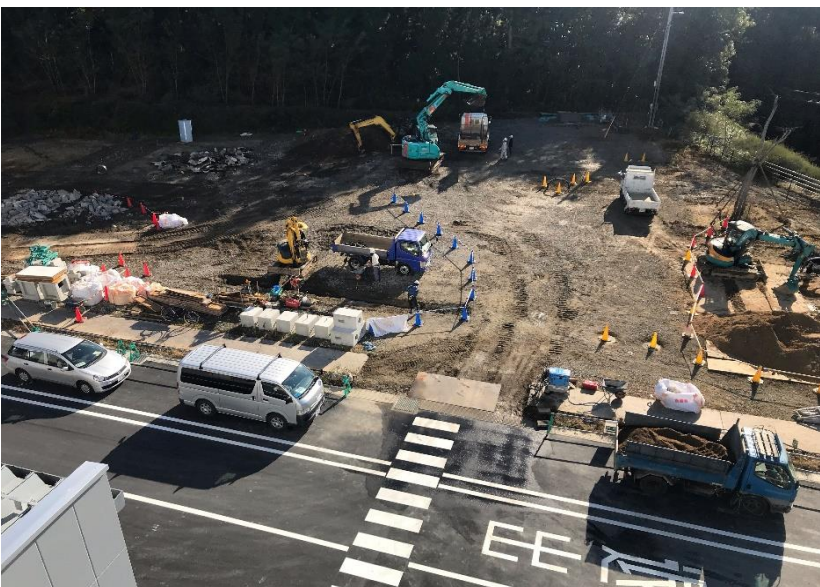
● 『エコの広場』 工事施工状況
