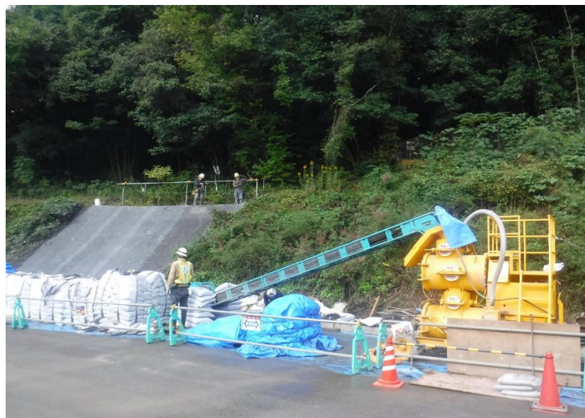
● 搬入路法面の復旧工事状況
