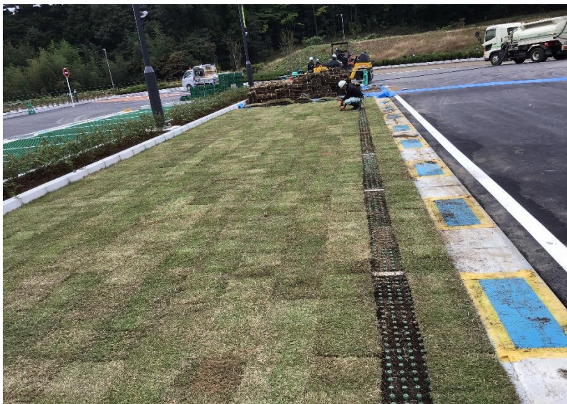
● 駐車場芝張施工状況
