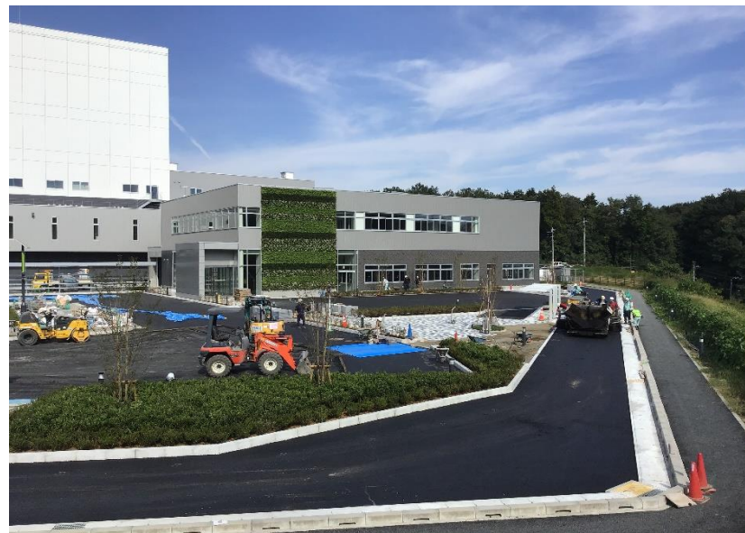
● 外構工事施工状況
