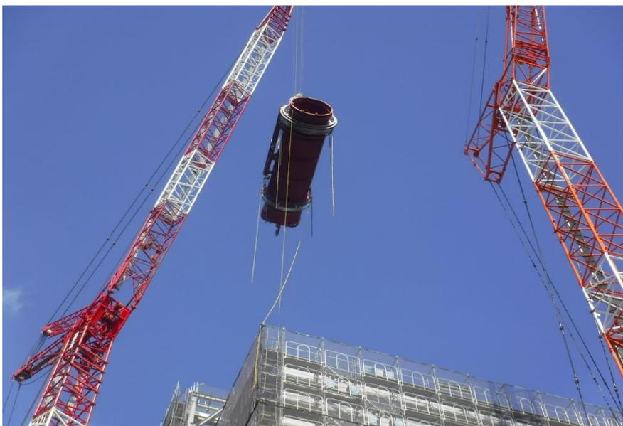
● 工場棟上部焼却炉本体搭載中
