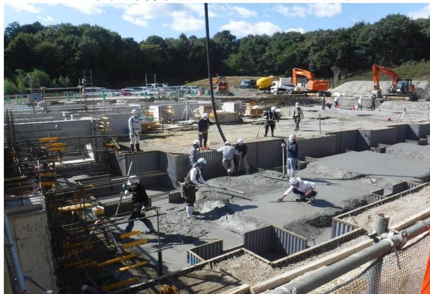
●管理棟捨てコンクリート打設状況
