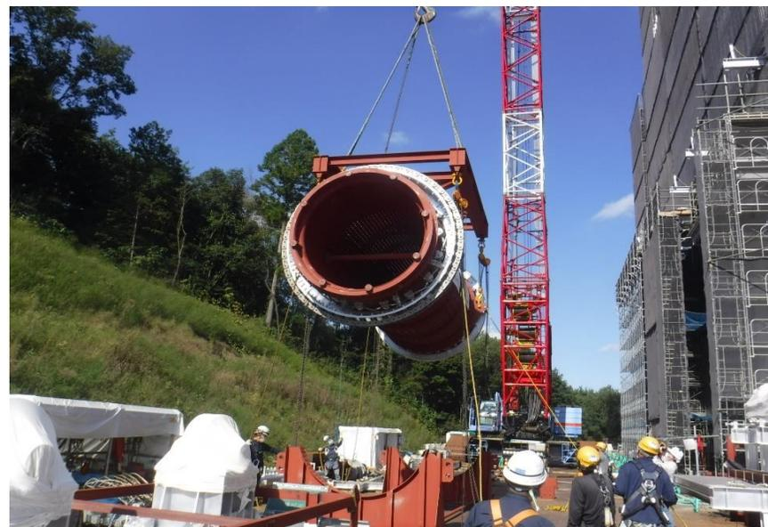
● 工場棟西エリア焼却炉本体搭載開始状況
