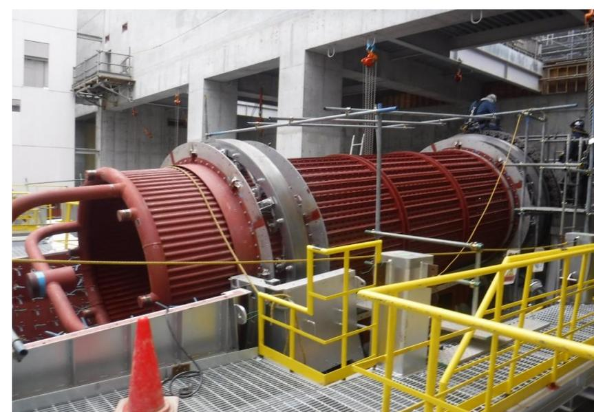
● 1工区焼却炉本体設置状況
