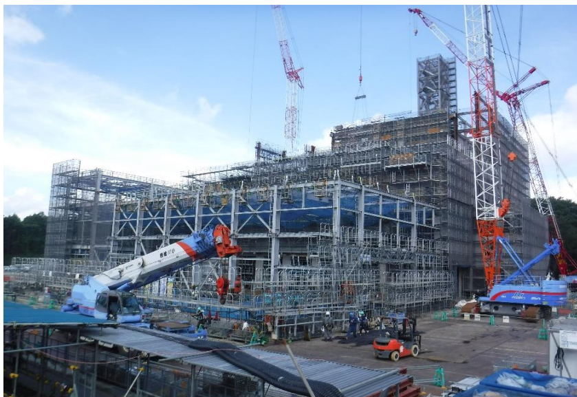
●3工区鉄骨組立作業状況（北東方向より）
