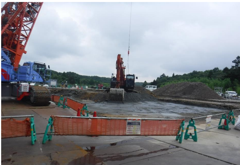
●管理棟エリア工事開始
