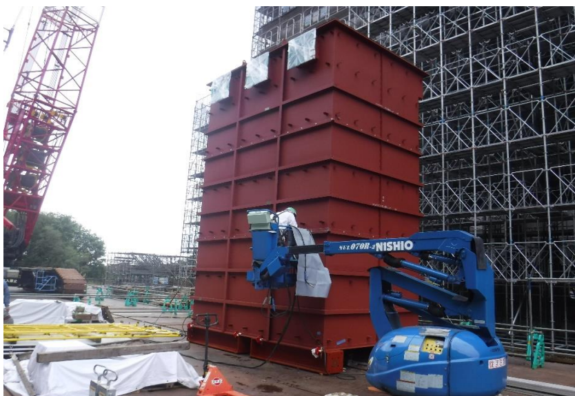
●ろ過式集じん器地組み作業状況
