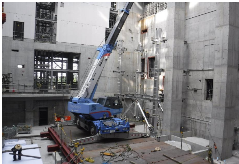
●1工区炉室内鉄骨組立作業開始
