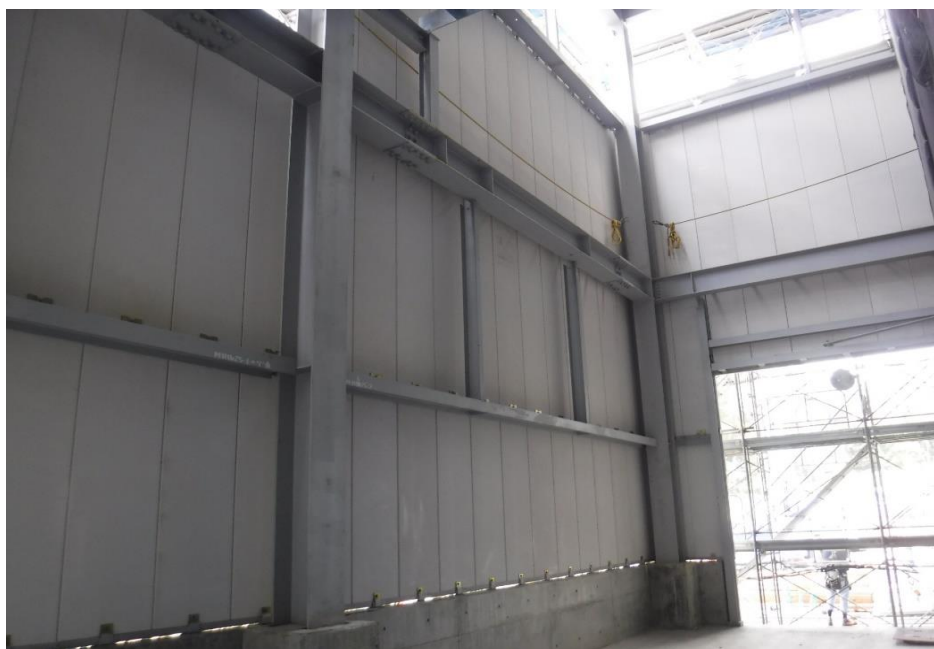
●灰積出場外壁ALCパネルの取付状況
