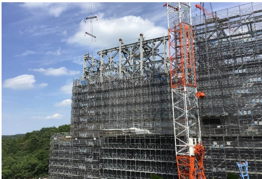
●1工区鉄骨取込み作業状況
