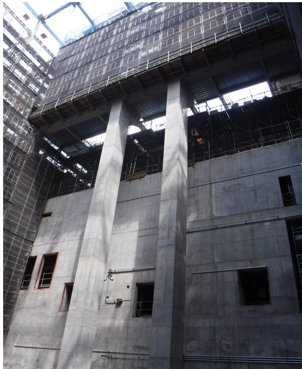
●炉室内東面下部の足場解体後
