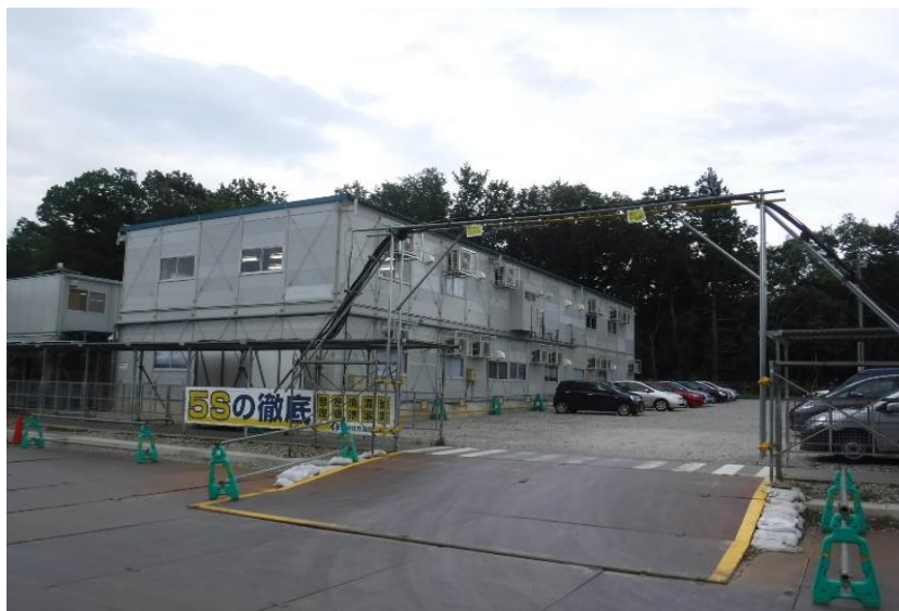
●プラント工事用仮設事務所設置
