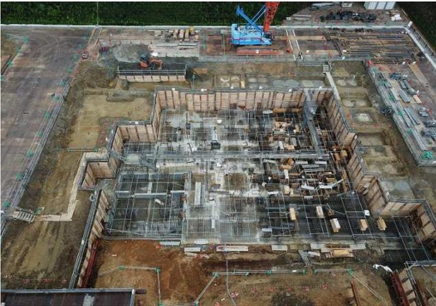
1工区：基礎・地中梁／配筋・型枠(炉室部分)
