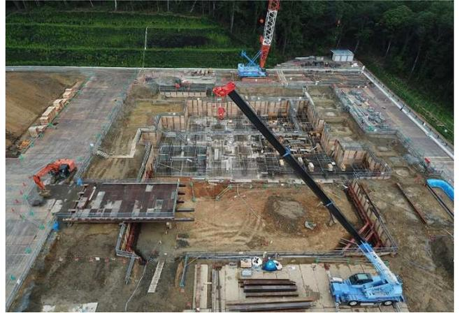
2工区：構台架設(ごみピット部分)
