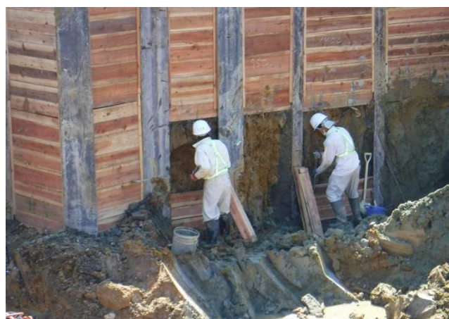
山留工事(横矢板)
