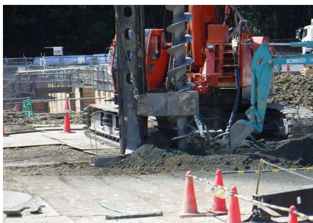
山留工事(山留杭)
