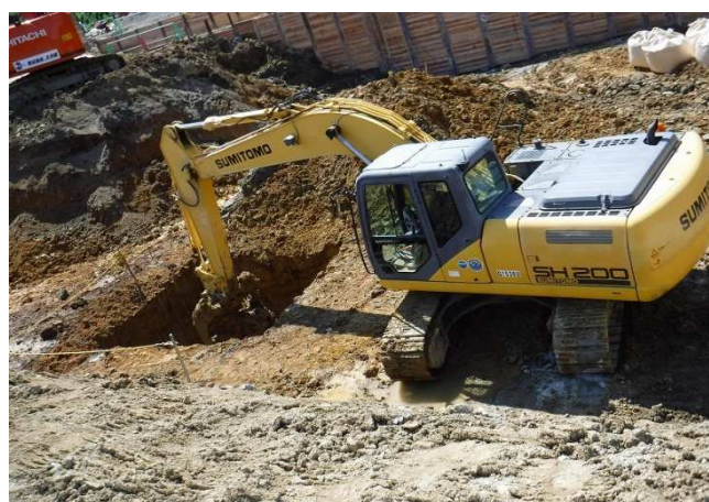
地盤改良工事(エルニード)
