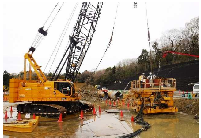
地盤改良杭工事
