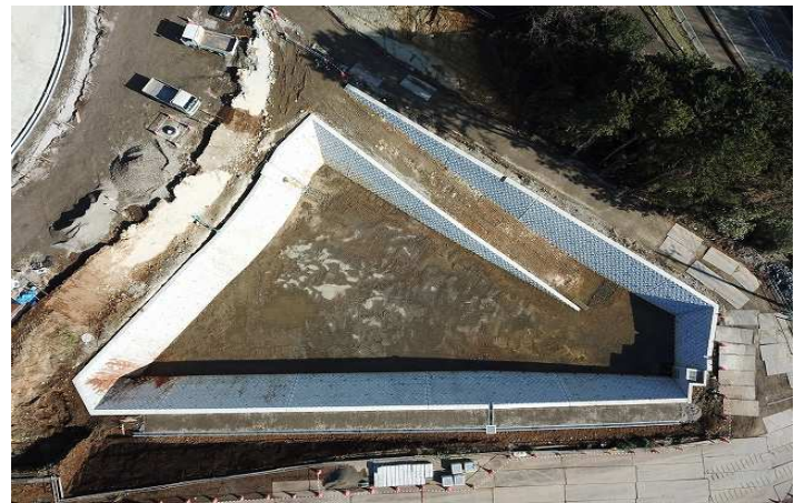
南側調整池工事
