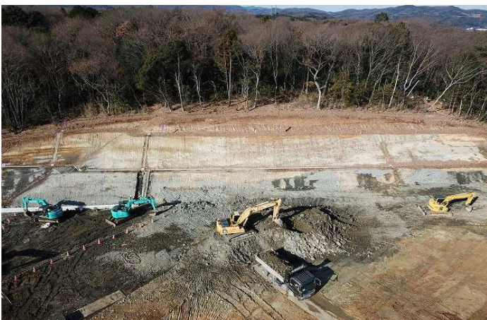
西側切土・法面整形
