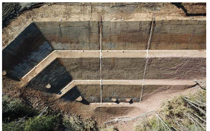
北側盛土・法面整形
