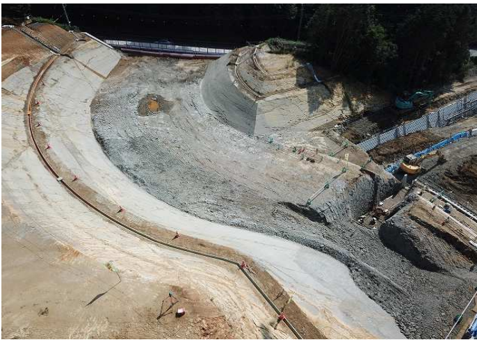
雨水排水工事
