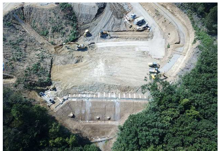
北側盛土・法面整形
