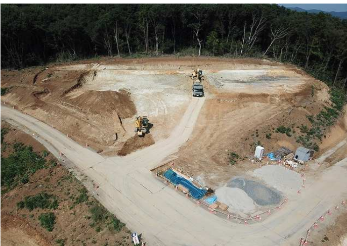
西側切土・法面整形
