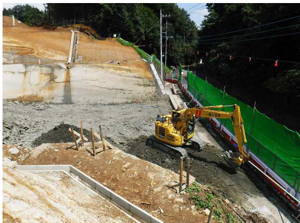
進入路 (掘削、既設ブロック撤去済)
